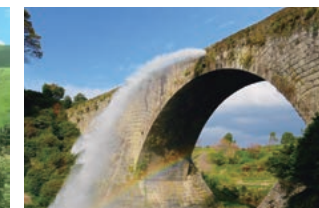
Pont de Tsujun
