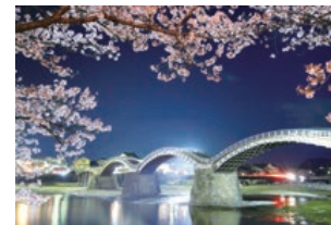
Pont de Kintaikyo
